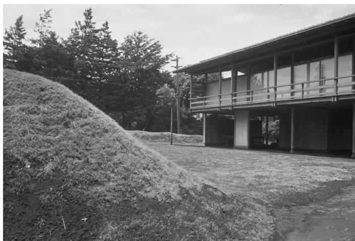
「成城の家」(丹下健三自邸) 撮影: 丹下健三 写真提供: 内田道子
